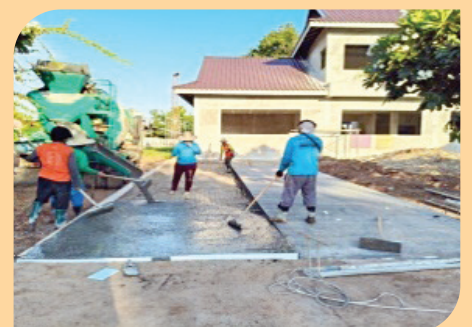
โครงการก่อสร้างลานคอนกรีตเสริมเหล็ก บริเวณรอบสำนักงานหลังใหม่ องค์การบริหารส่วนตำบลโพนงาม อำเภอลำดวน จังหวัดสุรินทร์
