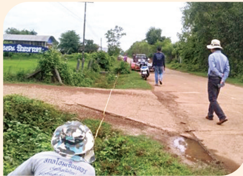
โครงการติดตั้งไฟฟ้าส่องสว่าง พลังงานแสงอาทิตย์ หมู่ที่ 1 ตำบลโพนงาม อำเภอลำลูกเกด จังหวัดสกลนคร
