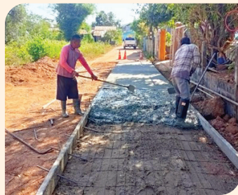
โครงการก่อสร้างถนนคอนกรีตเสริมเหล็กภายในหมู่บ้าน สายบ้านนางสมหญิงสุดช้อย บ้านชุมชนพัฒนา หมู่ที่ 8 ตำบลโพนงาม อำเภออากาศอำนวย จังหวัดสกลนคร
