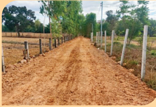
โครงการปรับปรุงถนนลูกรัง สายบ้านนายคอนสวรรค์- บ้านนายชวนชัย บ้านเสาวัด หมู่ที่ 12 ตำบลโพนงาม อำเภออากาศอำนวย จังหวัดสกลนคร
