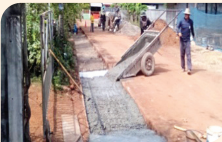
โครงการก่อสร้างขยายไหล่ทางถนนคอนกรีตเสริมเหล็ก สายหน้าบ้านนายสุวรรณ ด้านทิศใต้ บ้านเกษมสมบูรณ์ หมู่ที่ 9 ตำบลโพนงาม อำเภออากาศอำนวย จังหวัดสกลนคร
